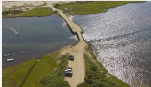
Kazanın olduğu dar köprü (Dike Bridge)
